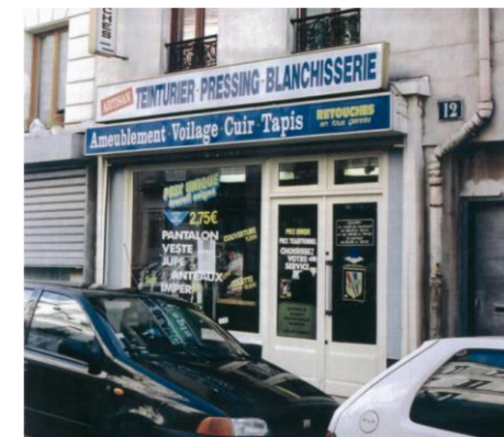
12 rue des Envierges (20 ème arrt) Avant changement de destination
